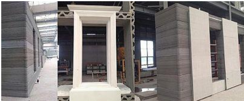
Рисунок 1 – Процес будівництва школи за новою технологією 3D принтера
