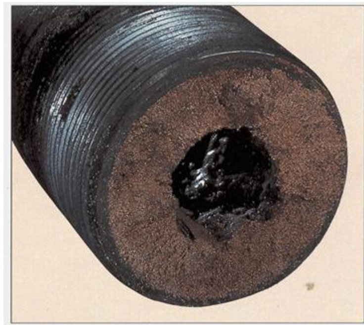
Рисунок 1 – Вигляд перерізу труби при наявності асфальтосмолопарафінових відкладень
