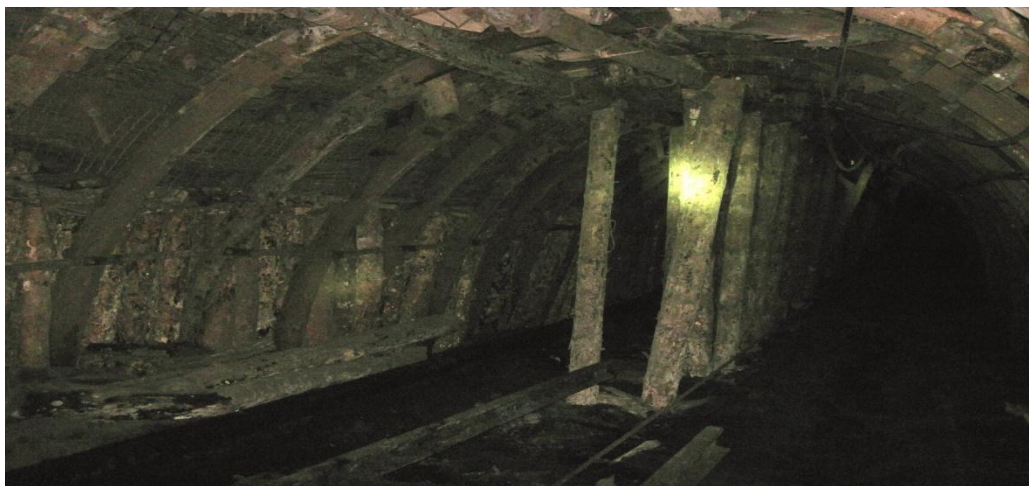
Рис. 7. Состояние выработки в 80 м за лавой
