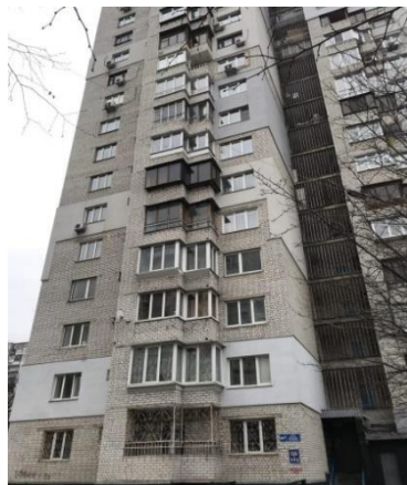
Рисунок 1 – Зовнішній вигляд огорожень житлової будівлі, що досліджується
